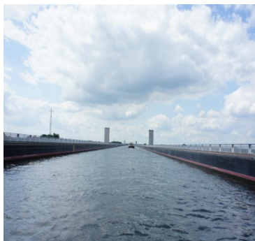
Aequadukt über die Elbe
