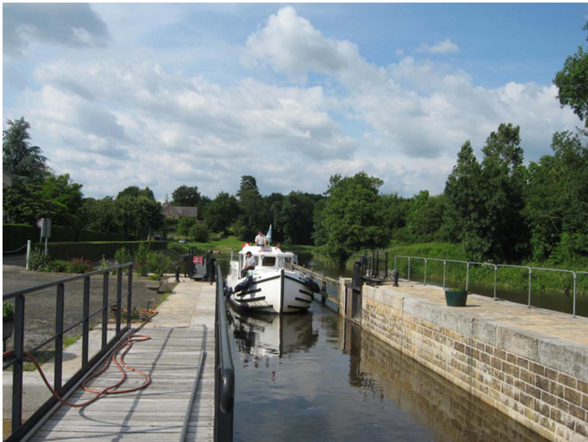
Mayenne, Schleuse Nr 40
