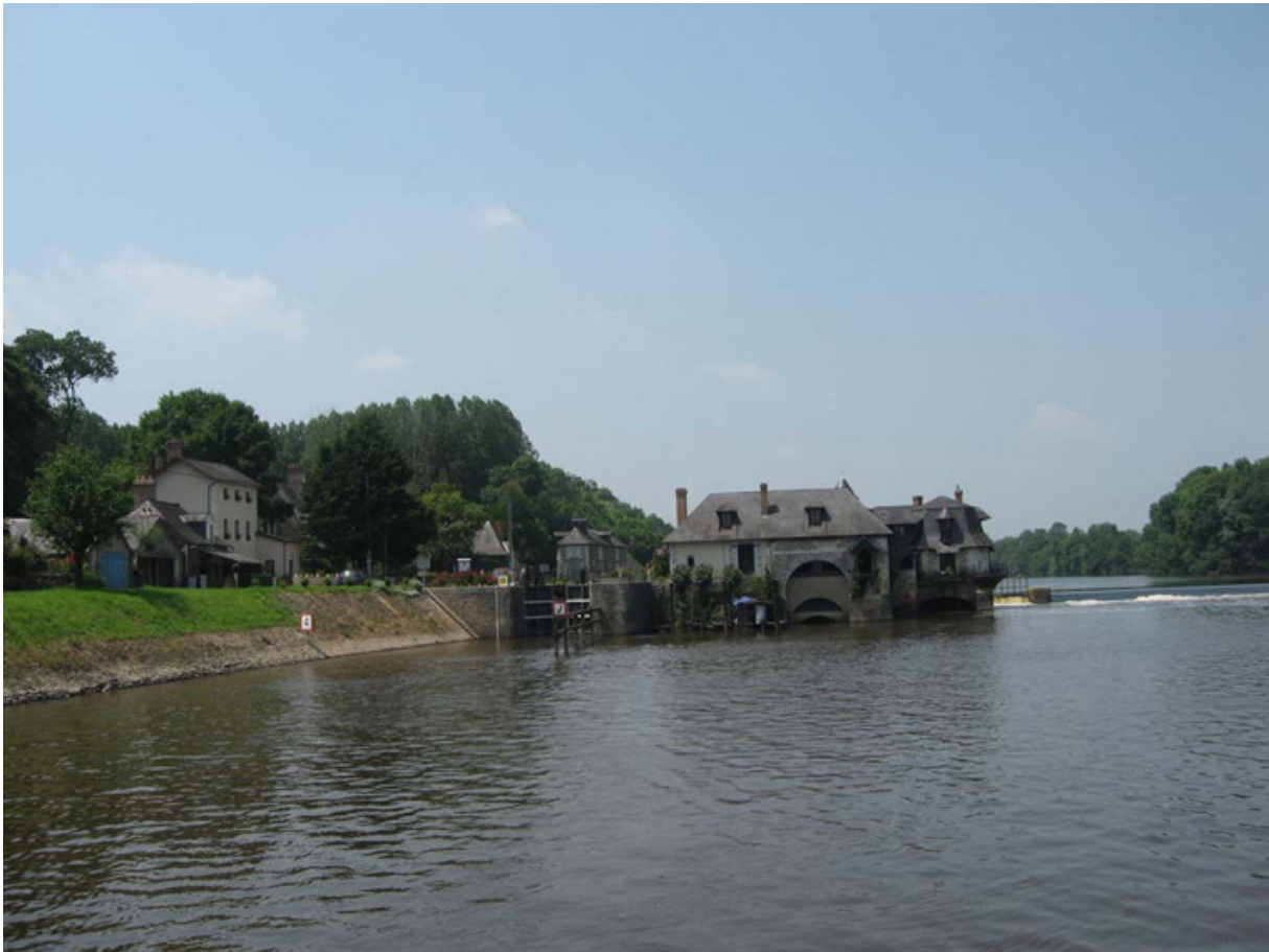
Mayenne, Schleuse Nr 43 alte Mühle
